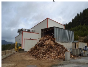
Фиг. 5.2. Общ вид на изградената централа
