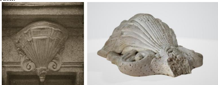
Фигура 21 Архивна снимка, показваща оригиналната форма на отчупения елемент
