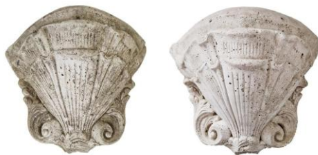
Фигура 13 Декоративен фасаден елемент преди и след почистване
